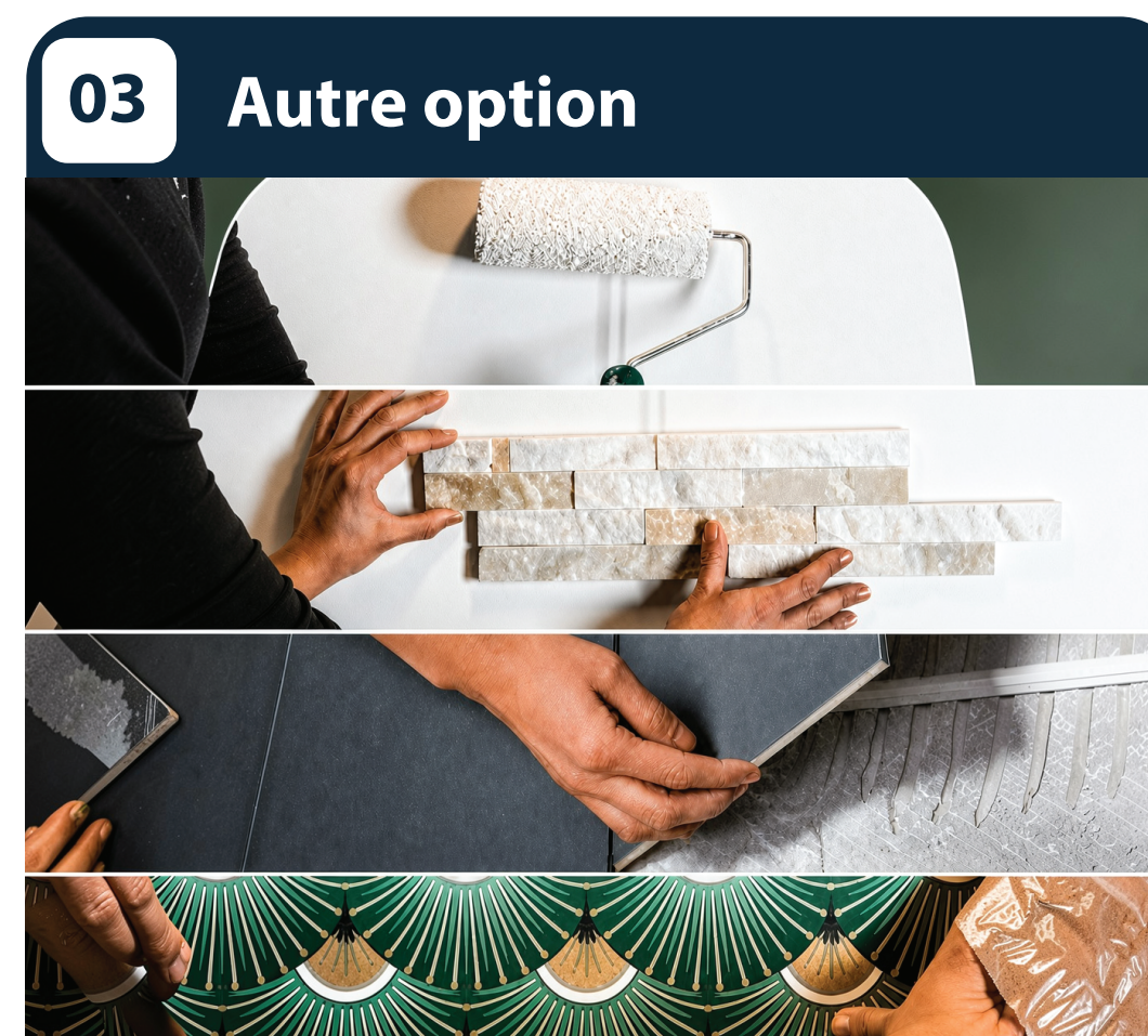
Appliquer plusieurs couches d'enduit + peinture ou du papier peint ou autre revêtement
