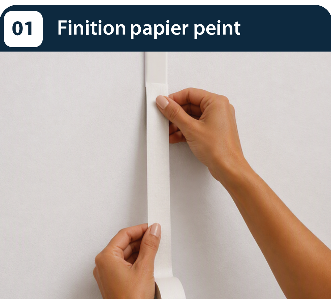
Appliquer le rouleau de papier peint à peindre fourni sur le câble.
